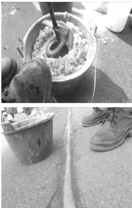
图8 树脂砂浆的拌和及切缝槽填补
