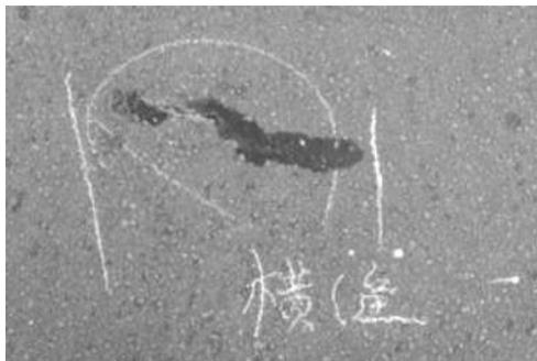
图10 西堍门大桥灌缝
